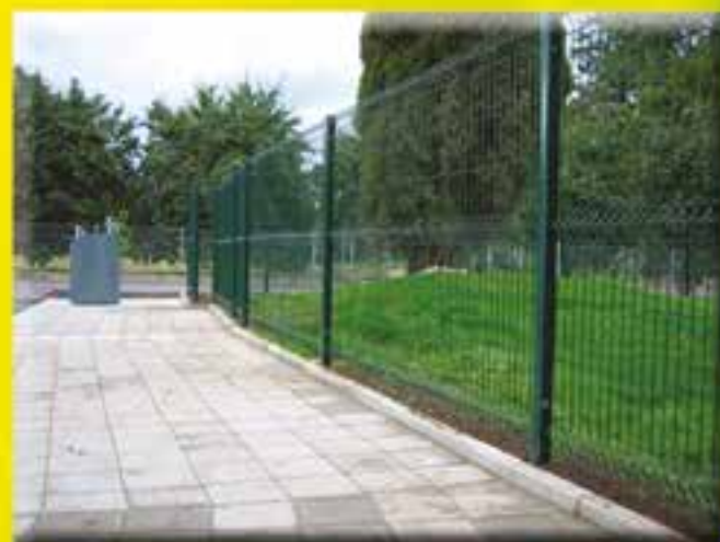
Clôtures et portails
